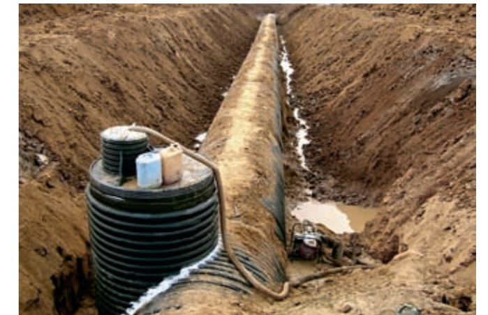
Фото 17. Тангенциальный колодец на коллекторе
