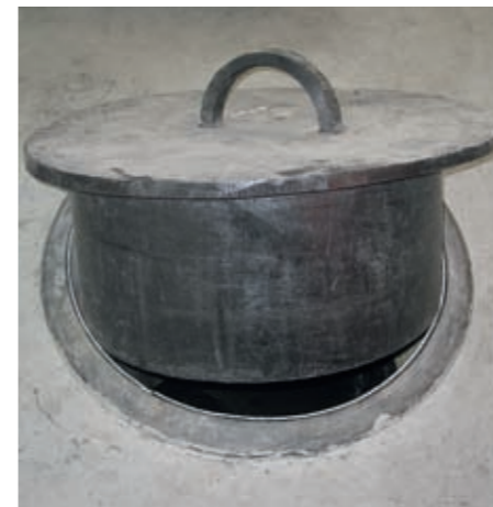
Фото 42. Сварная полиэтиленовая крышка
