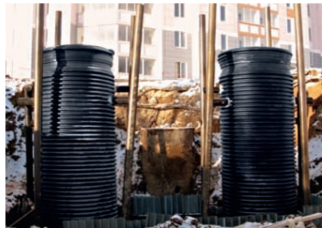
Фото 19. Монтаж корпусов КНС
