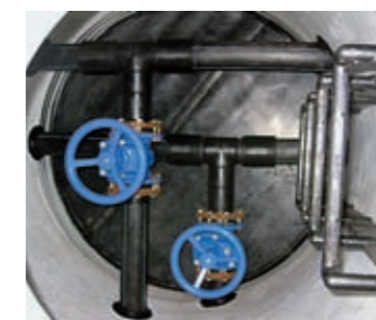
Фото 13. Вид инспекционной камеры сверху
