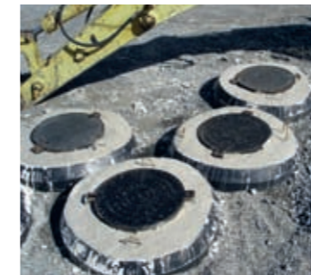
Фото 35. Пример использования формы для бетонирования
