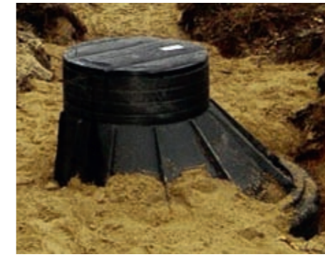
Фото 43. Вариант применения сварной полиэтиленовой крышки
