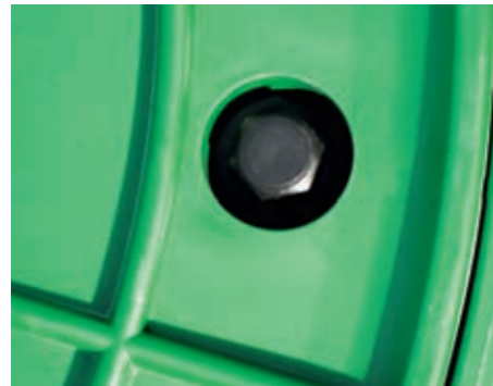
Фото 40. Запорное устройство люка (вид сверху)
