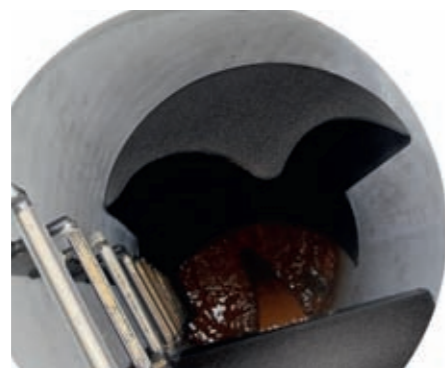
Фото 14. Обустройство перепадного колодца обеспечивает его обслуживание
