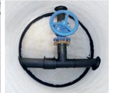
Фото 11. Вид инспекционной камеры сверху
